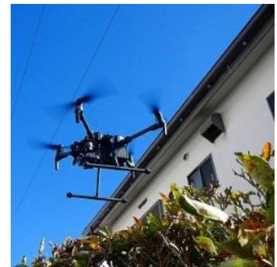
UAVsを活用した外壁点検業務
