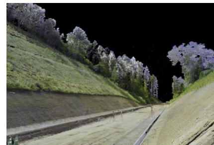
3次元レーザー測量
