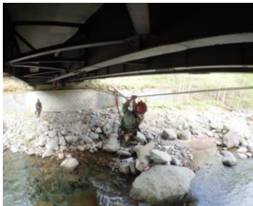
近接目視点検
