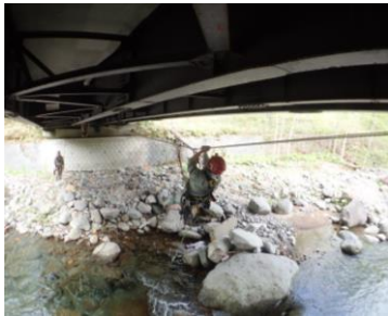
近接目視点検
