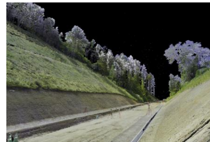
3次元レーザー測量
