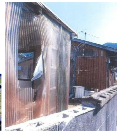
モジュールの飛散によって破損した民家
