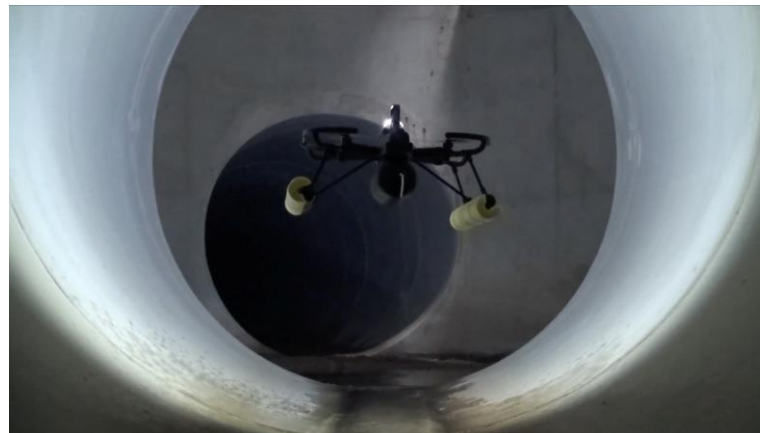
株式会社カンツール：管路点検ドローン
