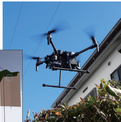
UAVs(ドローン)を活用した外壁点検
